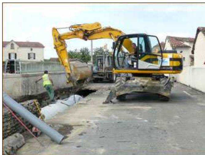
Travaux de sécurisation aux abords de l'école
