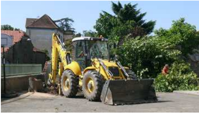
Cour de l'école : abattage des arbres
